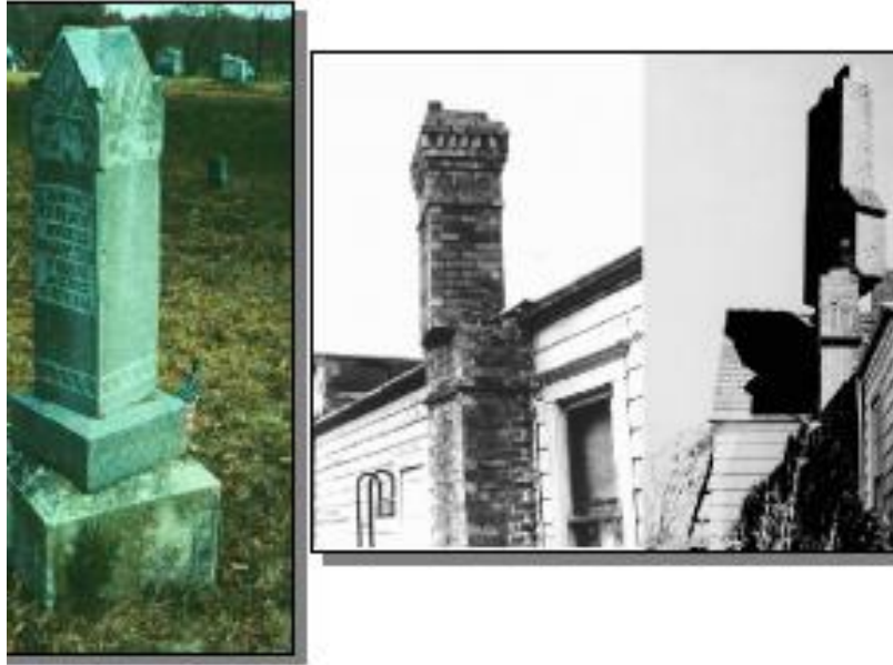
Figure 10. Photos empruntées à (Tobita and Sawada, 2006) montrant les rotations de parallélépipèdes rectangles à la suite d'une secousse sismique.
