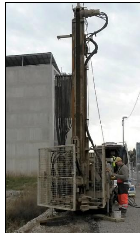
▲ Figure 2. Gauche : forage en cours à NIMR (photo Cerema, février 2017). Droite : le regard du capteur à 10 m avec la tête de forage d'où sort le câble du capteur Radian (photo M. Pernoud, Cerema, 9 octobre 2020).
