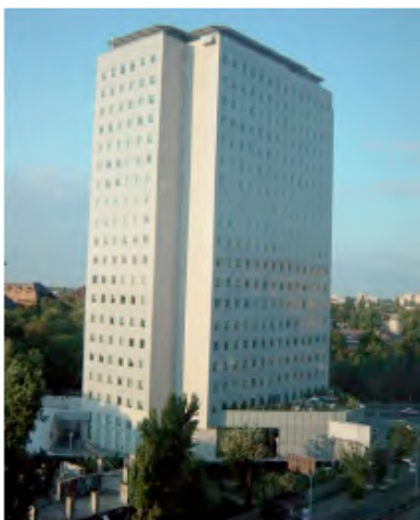
Bâtiment instrumenté : tour BRD (Société Générale) de Bucharest (Roumanie). Deux capteurs accélérométriques ont été installés en 2003 : un à la base du bâtiment et l'autre au sommet (Japan International Cooperation Agency).
